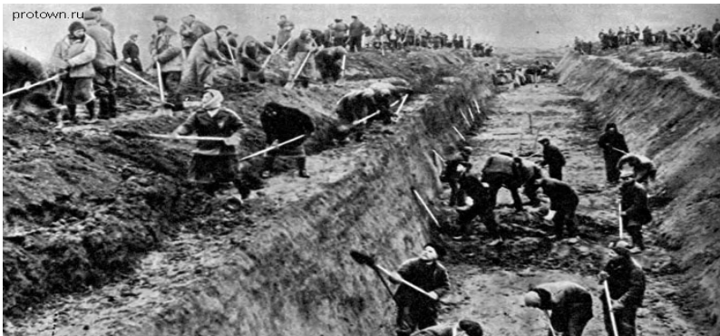
Рис.2 Строительство оборонительных сооружений под Москвой
