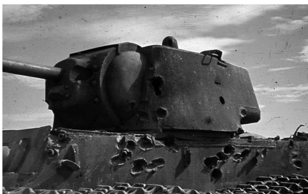
Рис. 3. Броня танка КВ после попаданий немецких снарядов.
